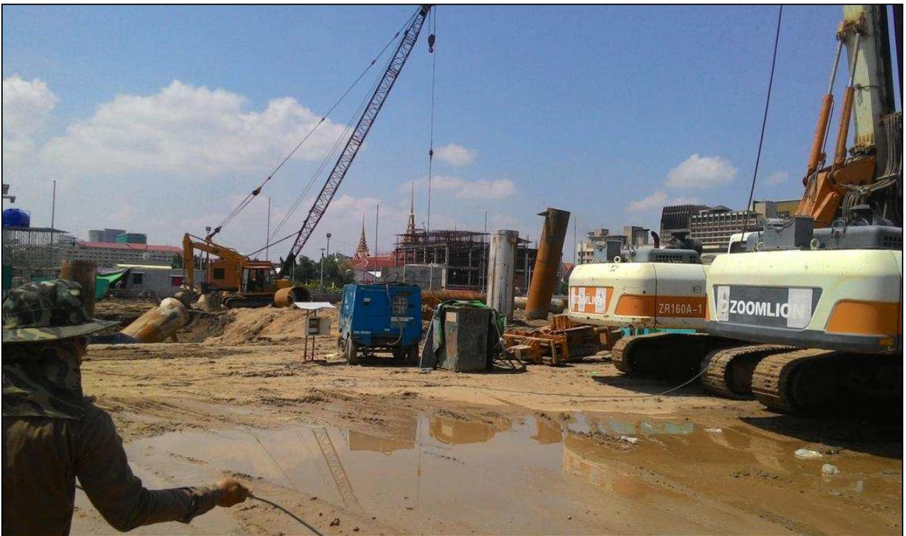
大型工程機具已進駐，施打基樁工程。
